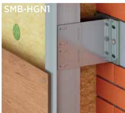
**RIVETTATO sottostruttura singola orditura**
