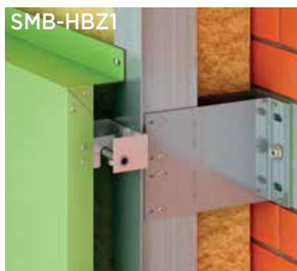
**BULLONE DI APPENSIONE sottostruttura singola orditura**
