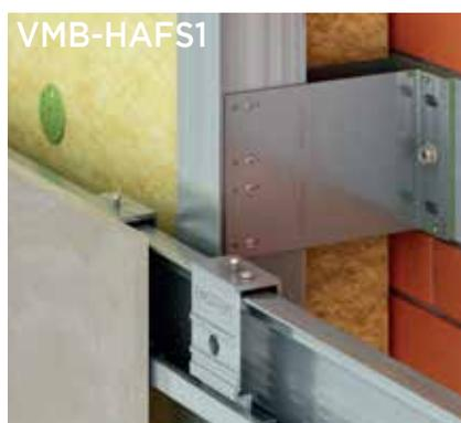
**FISSAGGIO CON AGRAFFE sottostruttura doppia orditura**
