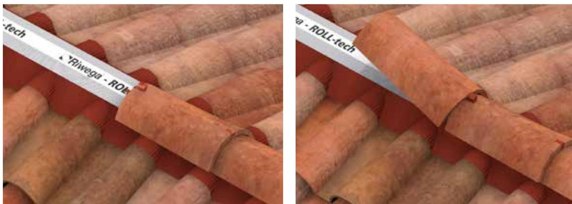
Sulla linea centrale del sottocolmo, in corrispondenza del listello in legno, vengono avvitati i ganci fermacolmo per il fissaggio meccanico delle tegole di colmo; la forma del gancio fermacolmo viene scelta in base al tipo di tegola di colmo utilizzata (in cemento, in cotto con sormonto liscio, in cotto con sormonto ad incastro).
