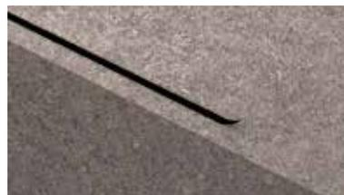
Si inizia la posa dell'SMT preparando il perimetro del tetto tramite l'**applicazione di una massa adesiva butilica** (USB Tape 2 BU) **o acrilica** (USB TAPE 2 AC BOLD) per garantire la tenuta all'aria ed al vento su tutti i lati della copertura\*.
