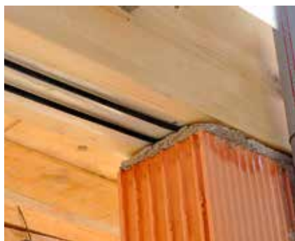
Versiegeln der Anschlussstelle auf der Mauerbank
