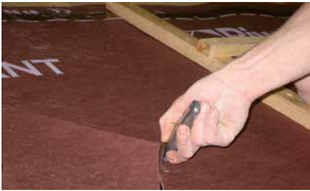
1. Zuschneiden der diffusionsoffenen USB-Dachbahn von Riwega
