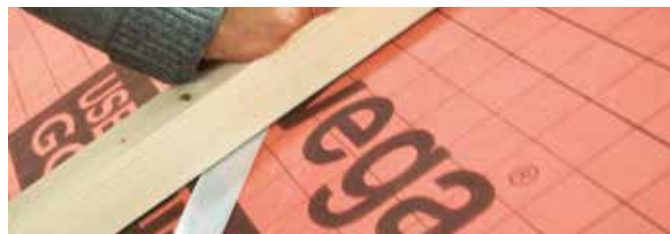
Verlegung des doppelseitigen Klebers USB Tip KONT DUO mit Entfernen des Liners
