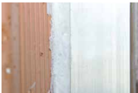
Ausfüllen zwischen Mauer und Blindstock
