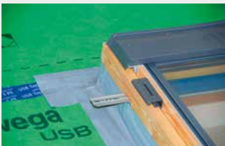
Komplettversiegelung des Fensters
