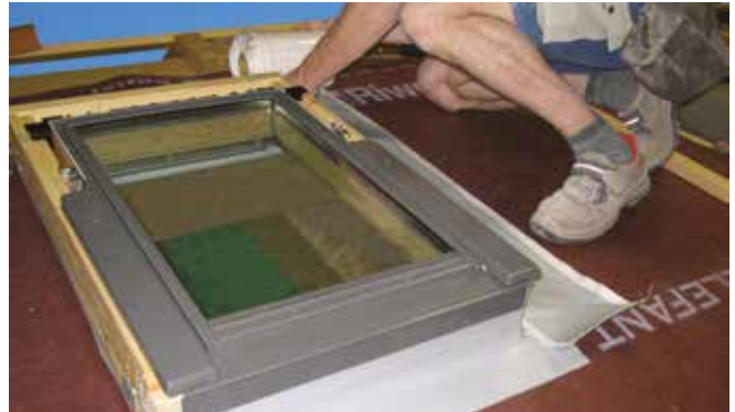
4. Das USB Coll 150 X an den beiden Außenseiten des Fensters anbringen
