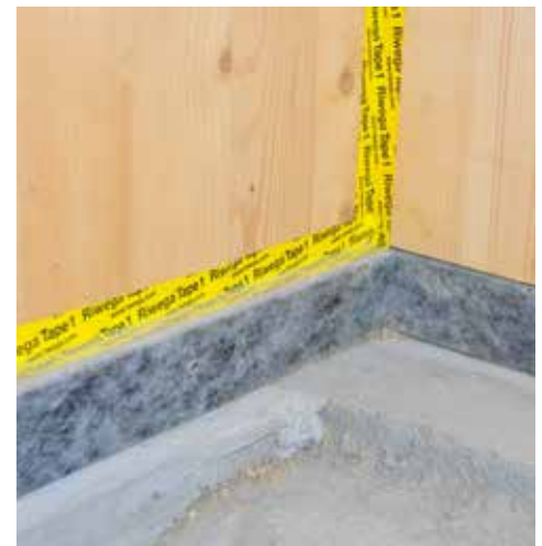
Abdichtung des Holzrahmens am Boden.
