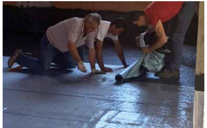
Verklebung der Radonsperre mit USB Coll Radon BIT
