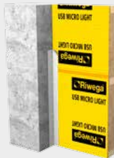
Abdichtung einer Dampfbremse am Übergang zu einer verputzten Wand
