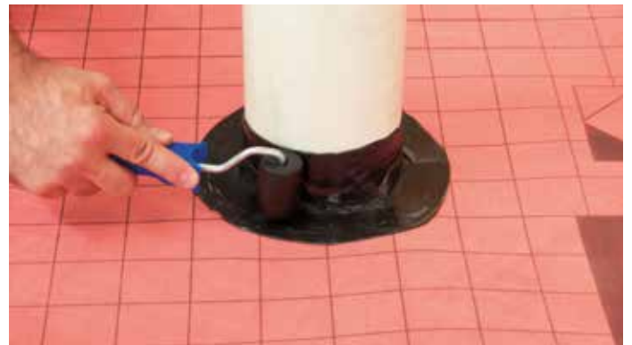
6. Mit der Andrückrolle an dem aufgehenden Bauteil festdrücken
