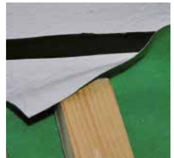
Versiegelung zwischen USB-Dachbahn und Wand
