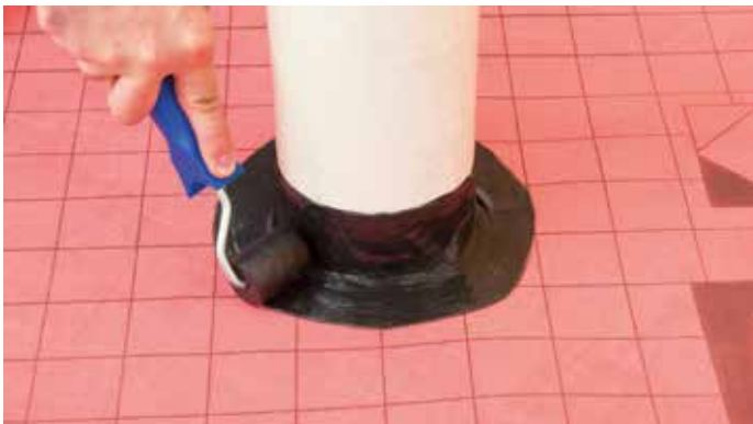
5. Mit Hilfe einer Andrückrolle auf der USB Riwega Bahn festdrücken
