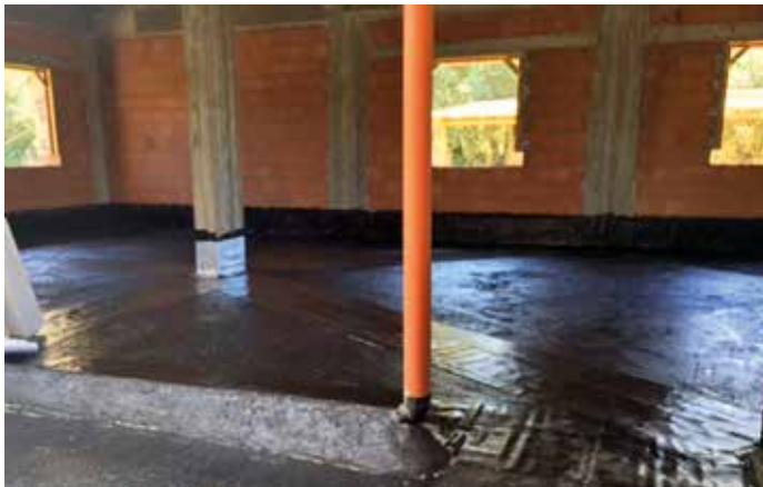
Vorbereitung der Oberfläche mit USB Primer BIT
