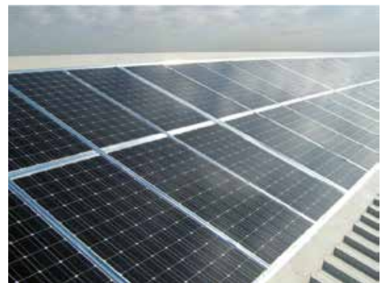
Versiegeln der Verbindungsstellen zwischen Solar- oder Photovoltaikpaneelen
