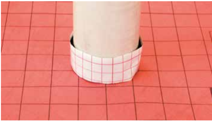
1. Verklebung der Hälfte des USB Coll Flexi auf dem aufgehenden Bauteil
