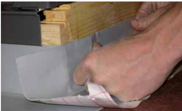
5. Verlegen des USB Coll 150 X Klebebands an der Oberseite des Fensters
