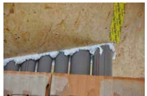
Auffüllen von Hohlräumen, Fugen und Zwischenräumen zwischen Bauelementen
