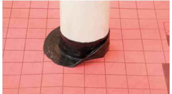
4. Den Rest des USB Coll Flexi modellieren
