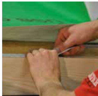
Versiegelung zwischen USB-Dachbahn und Holz
