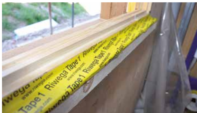
USB Tape 1 PAP X3 zur Abdichtung zwischen Blindstock und Holzwand
