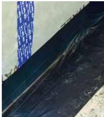
Abdichtung von Brettsperrholzwänden (X-Lam) am Boden
