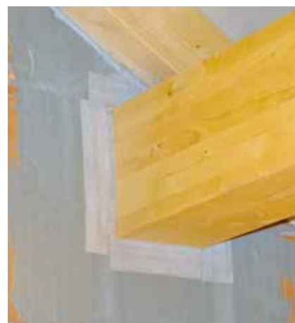
Abdichtung mit dem verputzbaren Klebeband USB Coll 75 zwischen Holzbalcken und Mauer
