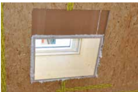
Auffüllen der Fugen an den Anschlüssen zum Rahmen von Dachfenstern
