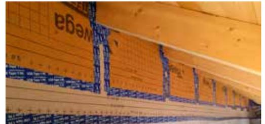
**Description du produit :** ruban adhésif professionnel et universel en polyéthylène avec trame de renfort enduit de colle acrylique à haute adhésivité, pour un usage à l'extérieur et à l'intérieur. À été spécialement conçu pour le collage des membranes et des écrans USB Riwega avec l'objectif d'étanchéifier à l'eau, à l'air, au vent, à la vapeur et aux bruits, chaque interruption de membranes sur l'ensemble isolant en toiture et/ou en façade.
