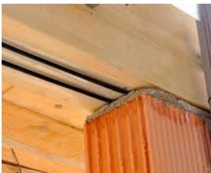
Étanchéité de l'appui de la poutre de soutien
