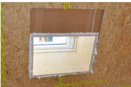
Remplissage des joints sur le périmètre des fenêtres de toit
