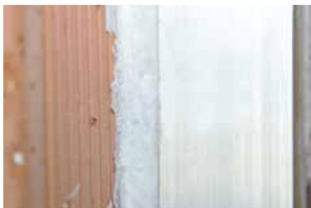
Remplissage entre maçonnerie et faux-montant
