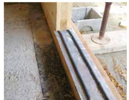
Étanchéité de l'appui d'une paroi en bois
