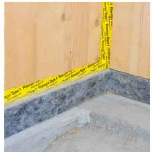
Étanchéité d'une paroi avec une dalle béton
