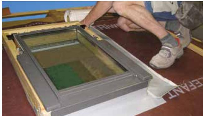
4. Pose de la bande USB Coll 150 X sur les deux côtés extérieurs de la fenêtre
