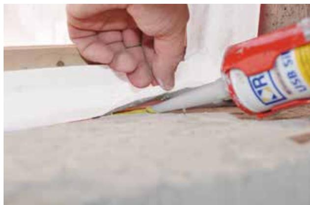
Collage de la bande extérieure FDB Tape Ext AC sur la maçonnerie.
