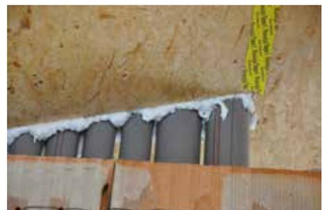
Remplissage des cavités, joints et interstices entre les structures du bâtiment
