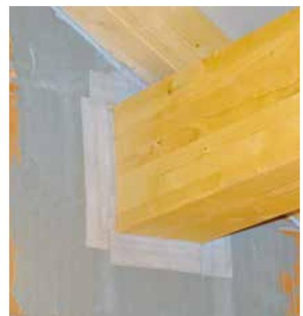
Étanchéité avec la bande à plâtrer Air Coll 75 X entre poutres en bois et la maçonnerie
