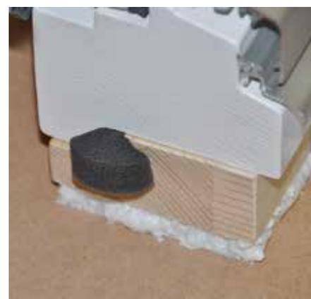
Scellement à l'air entre encadrement et faux-montants.
