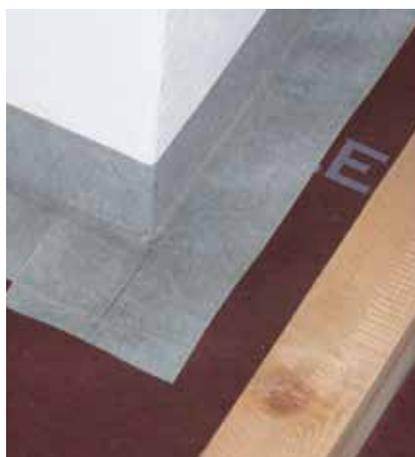
Étanchéité d'une cheminée avec AIR Coll 150 X avec la possibilité de plâtrer successivement
