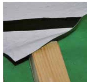
Scellement entre écrans de sous toiture et maçonnerie
