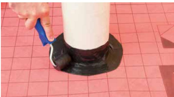
5. Pression au moyen de la roulette, sur la membrane USB Riwega
