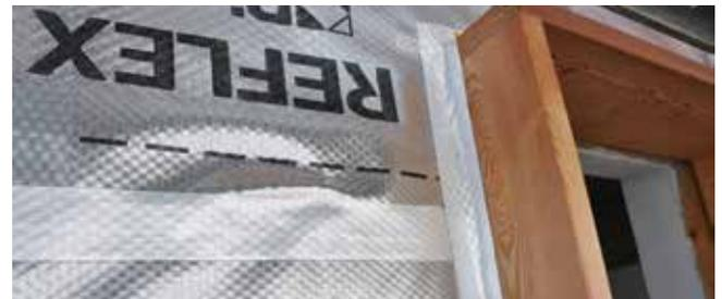
Fixation de la membrane USB Reflex Plus sur les fenêtres
