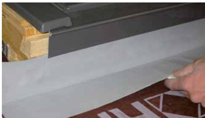
2. Pose de la bande USB Coll 150 X sur le côté bas de la fenêtre
