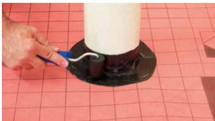
6. Pression au moyen de la roulette, sur le tube.
