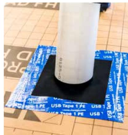
le appliquer le patch, celle-ci devant être sèche et sans poussières; insérer le câble ou le tube dans la collerette pour qu'elle puisse exercer une forte pression autour du tube; faites glisser le patch jusqu'à la surface sur laquelle doit être collée; Mettre directement à la base de la collerette, directement sur la surface de l'écran frein-vapeur USB Riwega; exercer une forte pression en passant la roulette afin de faire parfaitement adhérer la totalité de la base sur la surface.
