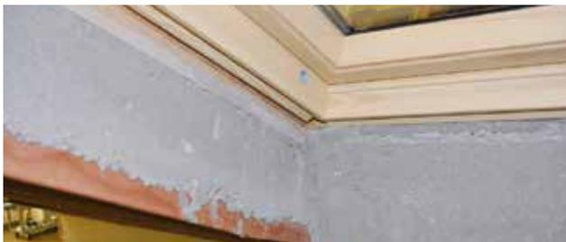
1. Se il foro è ricavato in una falda in laterocemento si presenta il doppio problema della sigillatura e del supporto per l'intonaco.
