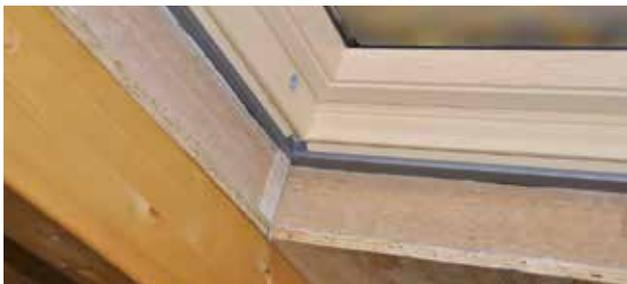
1. Il foro per finestra ricavato da un pacchetto tetto già esistente presenta notevoli problemi di coibentazione, tenuta all'aria e formazione di condensa.
