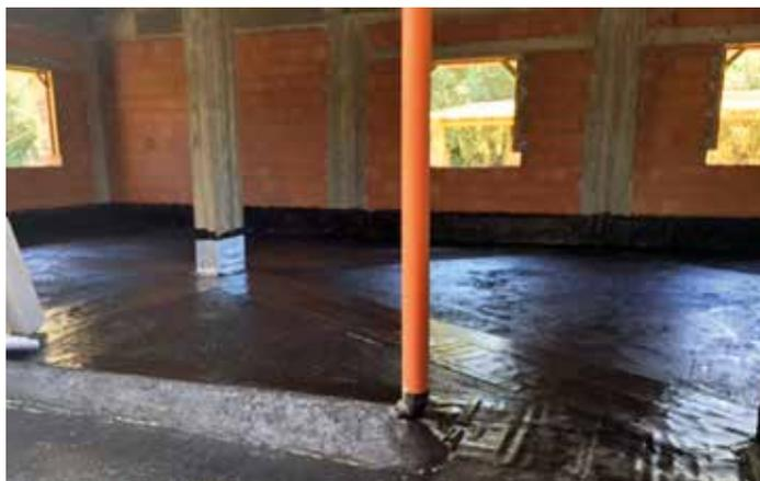
Preparazione della superficie con USB Primer BIT
