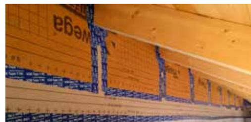
**Descrizione prodotto:** nastro adesivo professionale e universale in polietilene con rinforzo retinato spalmato di colla acrilica ad alta tenuta adesiva, per uso esterno ed interno. È stato appositamente studiato per l'incollaggio delle membrane e schermi USB Riwega con lo scopo di impermeabilizzare all'acqua, all'aria, al vento, al vapore e ai rumori ogni interruzione dei teli sul pacchetto tetto e/o parete.
