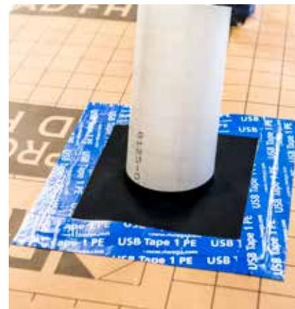
essere asciutta e priva di polveri; inserire il cavo o il tubo nel collarino in modo che quest'ultimo eserciti una pressione tenace intorno al tubo; far scorrere la guarnizione fino alla superficie sulla quale deve essere incollata; rimuovere il liner protettivo e far aderire la parte adesiva del nastro USB Tape 1 PE sulla superficie di appoggio; esercitare una forte pressione con l'apposito rullino in modo da fare aderire perfettamente tutta la base sulla superficie.
