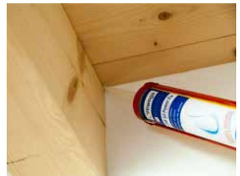
Esempi di utilizzo per ripristinare la tenuta all'aria di fessure presenti nelle strutture
