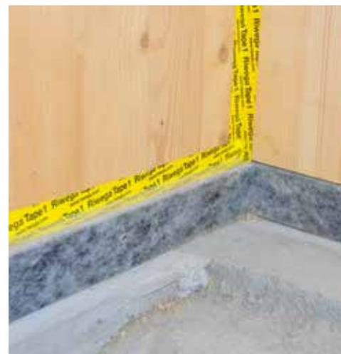
Impermeabilizzazione della trave di banchina a terra
