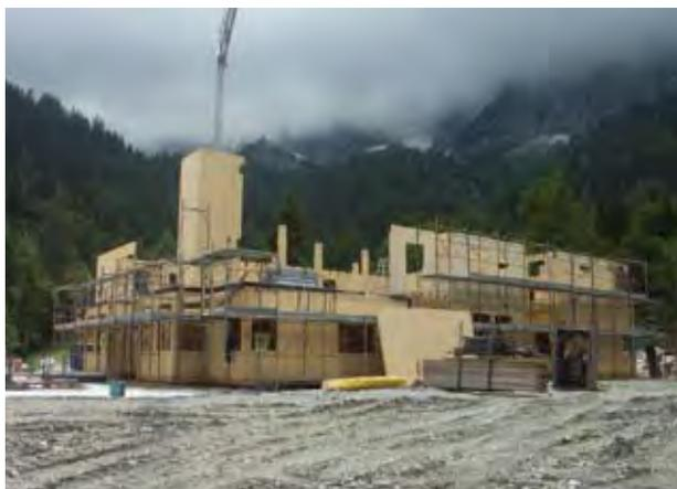
Fig. 7.14 - Costruzione a pannello
