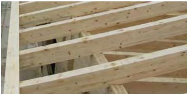
Fig. 6.1 - Giunzione correntini – banchina in appoggio
