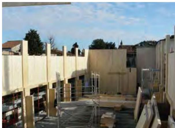
Fig. 7.15 - Costruzione a pannello
