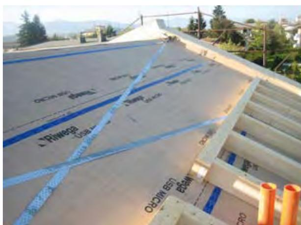
Fig. 9.6 - Posa del nastro forato
