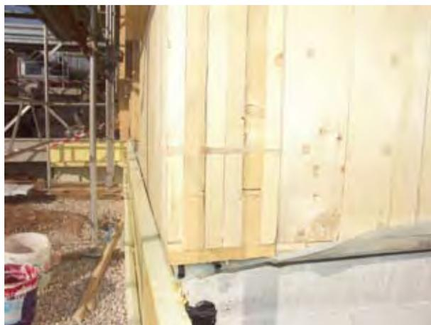
Fig. 7.12 - Costruzione a pannello fissato con perni
