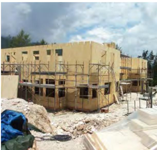
Fig. 7.1 - Costruzione multipiano a pannello
