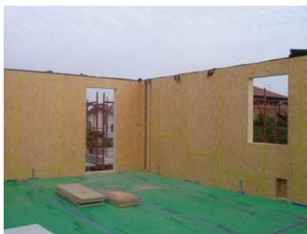
Fig. 7.4 - Costruzione a telaio vista dall'interno
