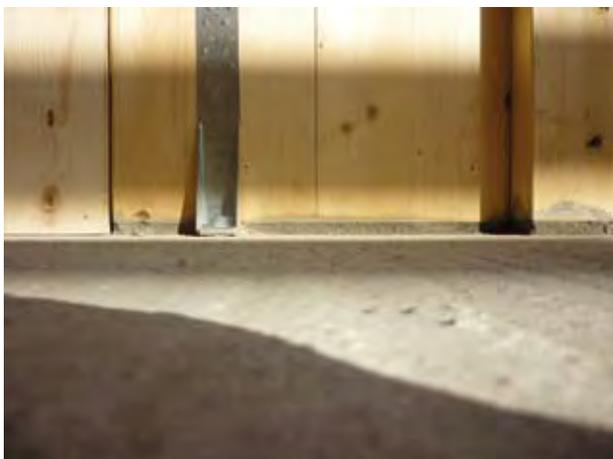
Fig. 9.13 - Riempimento con malta espansiva anti-ritiro
