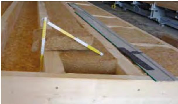
Fig. 7.9 Struttura a telaio in fase di montaggio
