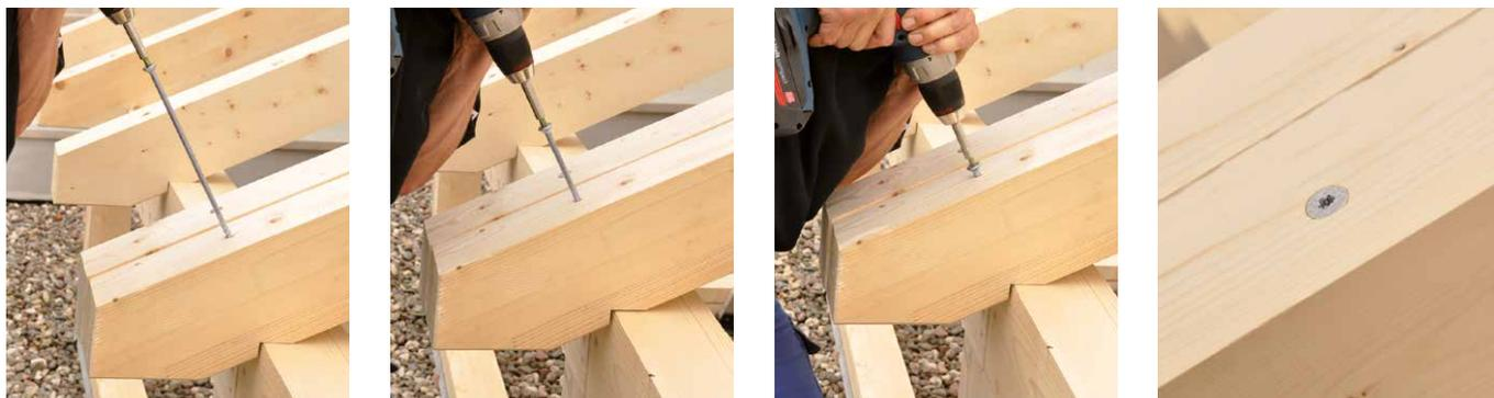
Le lunghezze delle viti sono indicative e vanno verificate di volta in volta in base alle dimensioni degli elementi strutturali.
