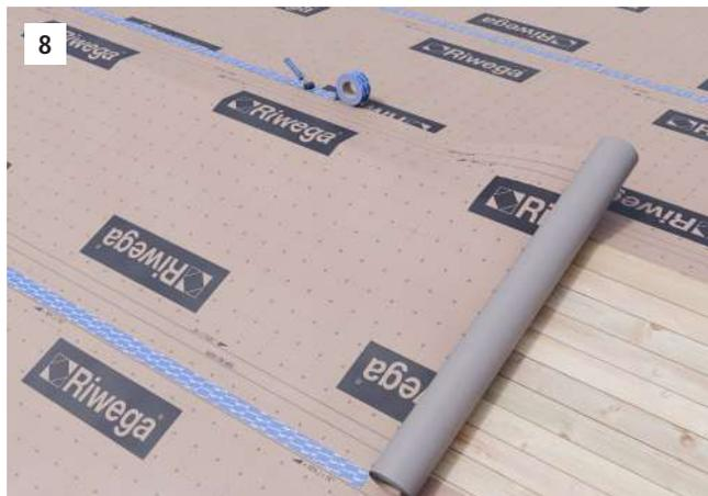
In corrispondenza della linea di colmo, risvoltare il freno al vapore di almeno 20 cm sulla falda adiacente e sigillarlo sul freno al vapore già precedentemente posizionato.
