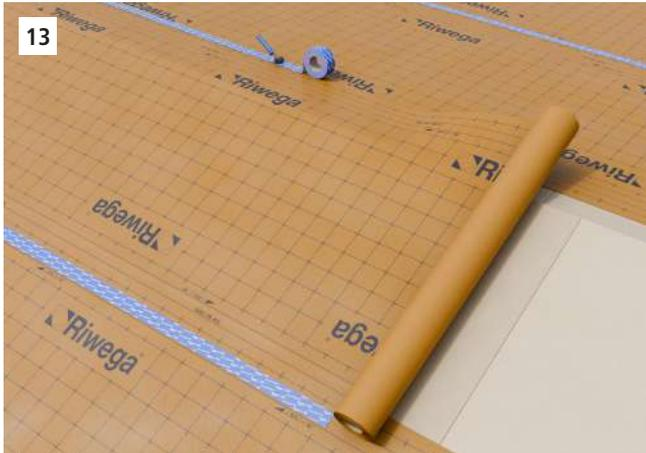
13 In corrispondenza della linea di colmo, risvoltare la membrana traspirante di almeno 20 cm sulla falda adiacente e sigillarla sulla membrana traspirante già precedentemente posizionata.
