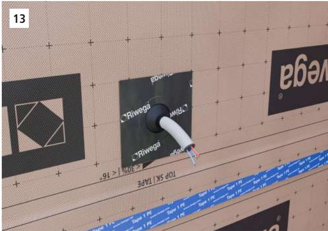
Nel caso in cui gli impianti si intersechino con il freno al vapore, sigillare a regola d'arte l'interruzione con appositi sistemi quali collarini di tenuta e/o idonei materiali di tenuta in genere.
