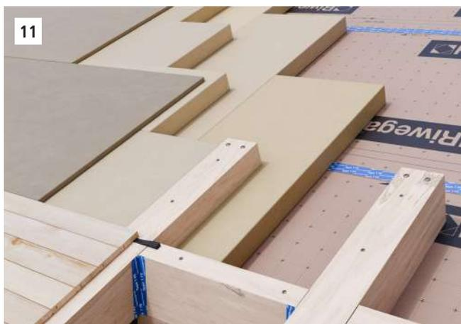
Posizionamento dei pannelli coibenti in più strati incrociati e a giunti sfalsati per massimizzare la prestazione termica e ridurre al minimo il rischio di ponti termici.
