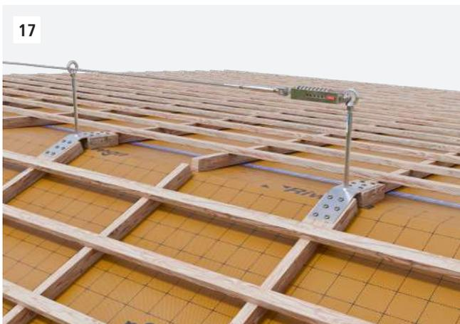
17 Posizionare i sistemi di sicurezza, quali linee vita e/o ganci di ancoraggio, esternamente al pacchetto tetto per evitare ponti termici causati dagli elementi metallici e fissarli con viti di lunghezza adeguata.
