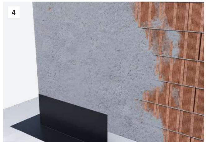
4 Impermeabilizzare il piede esterno della parete tramite apposita guaina adesiva e antiradice. Se necessario utilizzare il primer. Assicurare anche la tenuta al vento della connessione tra la parete e il cordolo.
