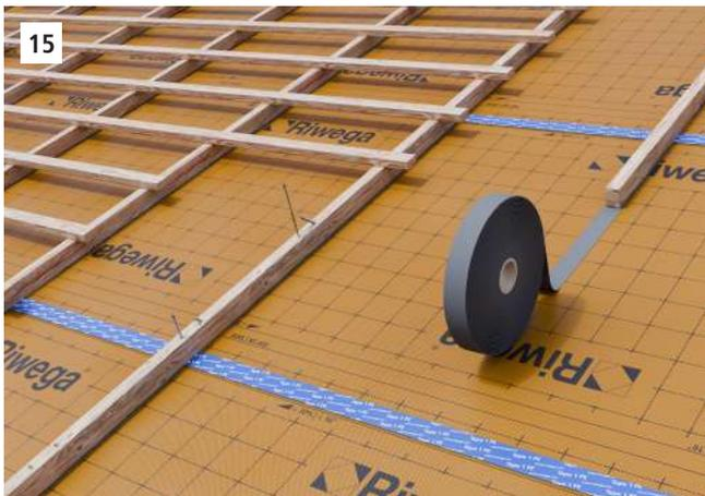
15 Utilizzo della guarnizione punto chiodo, continua o a punti, da posizionare sulla membrana in corrispondenza dei listelli, oppure direttamente sui listelli nella versione biadesiva.
