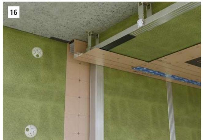
Particolare di ripresa del freno vapore in parete con il freno vapore posato sul soffitto. Dettaglio di sigillatura dei due teli per assicurare la tenuta all'aria lungo tutto lo spigolo tra parete e soletta.
