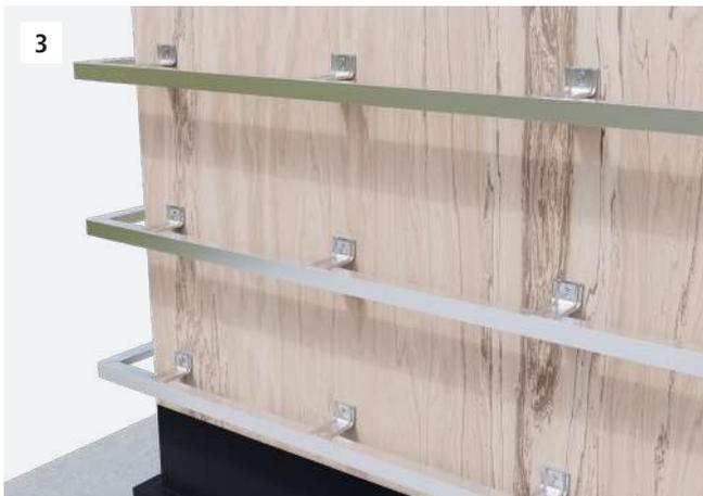
3 Nel caso di facciata ventilata, posizionare staffe SPIDI e profili in alu, considerando le distanze minime per assorbire le dilatazioni. Valutare i fissaggi sulla base della struttura portante e del tipo di finitura.
