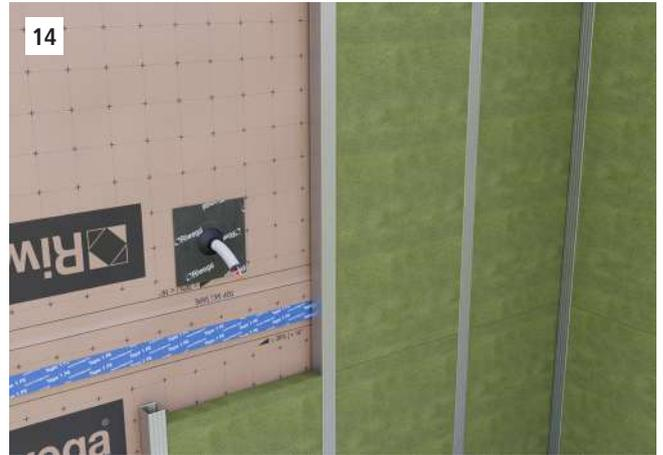
Nel caso di una controparete interna, riempire il vano del passaggio impianti con idoneo materiale isolante a bassa densità per migliorare sia le prestazioni termiche che acustiche della parete perimetrale.
