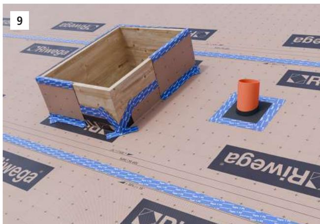
Sigillare tutte le interruzioni delle membrane, quali fine rotolo e/o elementi di passaggio, quali ad esempio camini, sfiati, finestre da tetto e impianti, con appositi nastri adesivi.
